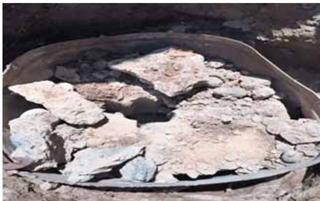
▲ Рис. 9. Монолитный бетонный блок с составом № 1 ▲ Fig. 9. Monolithic concrete block with composition № 1
